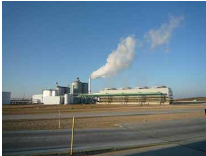
操業中のエタノール工場
