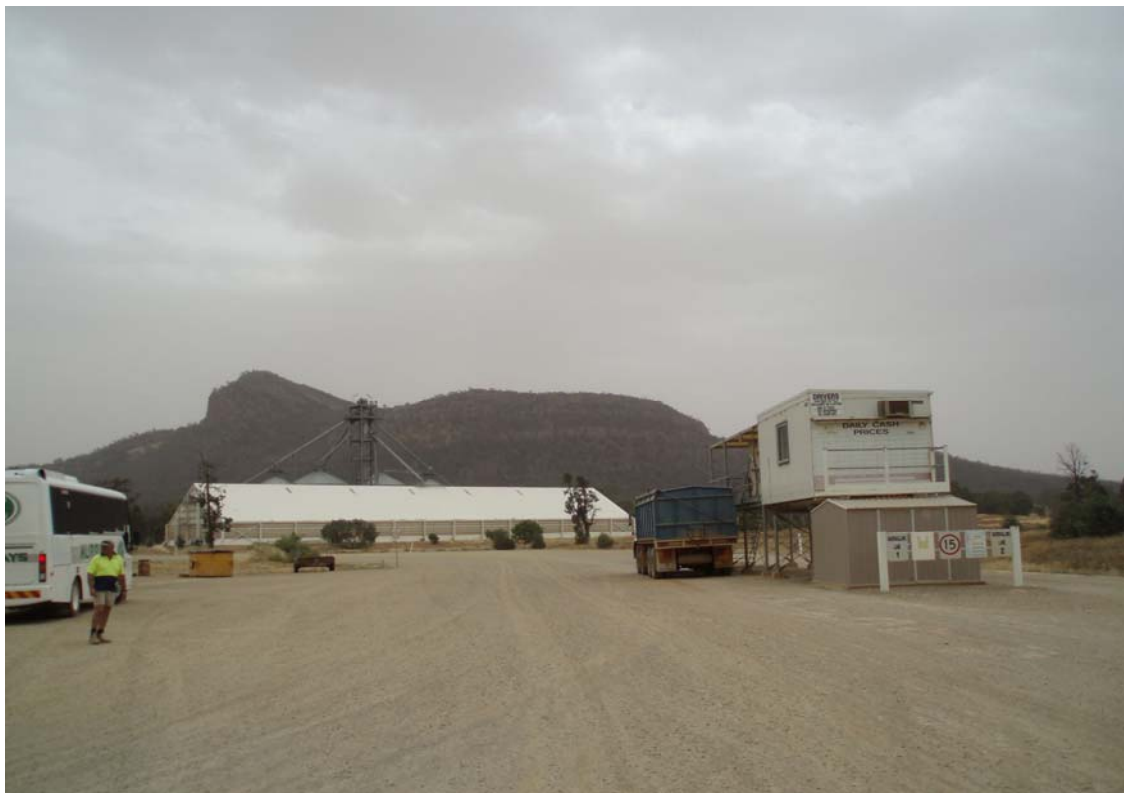
小麦受入集荷施設－右側の小さな建物がサンプル検査場
